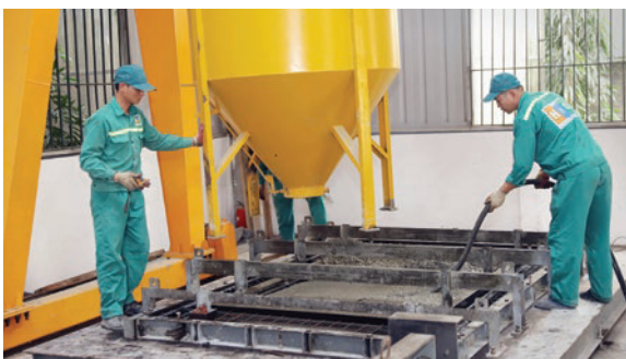
3. Đổ bê tông
